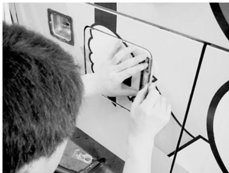
◀次は細かい作業です。定規とカッターを使ってバスの形にフィットさせるように、ていねいに切り離していきます。
