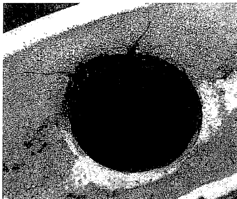
B：ホイールボルト穴の座面の亀裂
