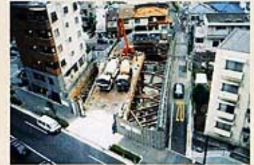
(地下躯体工事)
