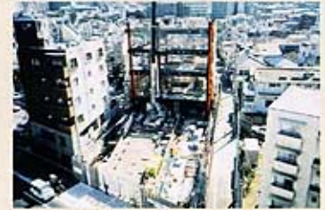
(地上鉄骨建方工事)
