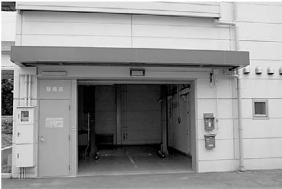
燃料電池自動車の整備室入り口。室内は今までの整備作業場とは異なり、万一の水素漏洩時に火災や爆発が起こらないよう、室内換気・空調を始め静電気対策や防爆型電気設備の採用など、徹底した防爆・火災対策が施されている。
