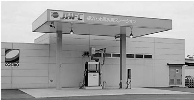
水素ステーション全景。ディスペンサーと呼ばれる水素供給設備の後ろの建物内は全て水素製造・貯蔵設備となっている。ちなみに、水素スタンド1基の建設費用は、現時点では同規模ガソリンスタンドの3倍程度だという。
