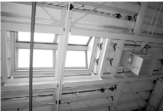
整備室内天井にある「放風窓」。万が一爆発した際のエネルギーを逃すための設備。
