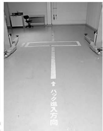
一見すると何でもない整備室の床。だが、静電気を逃がすための塗装が施されている。
