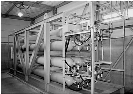
水素蓄圧器。簡単に言うならば、水素貯蔵庫。自動車に燃料を充填する水素ステーション側は、車載タンク圧力よりも高い圧力で水素ガスを貯蔵する必要があるため、約400気圧もの高い圧力に耐えられるように設計する必要がある。今後は、燃料電池自動車の1充填当りの走行距離を伸ばすため、車載タンクおよび水素ステーションの圧力はますます高圧化すると予測される。
