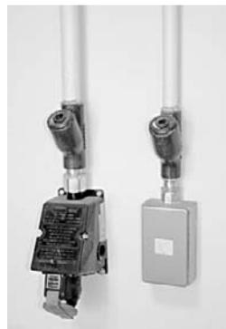
整備室内に採用されている防爆型コンセント。通電時に火花が出ないように特殊コンセントを使用している。(写真左)
