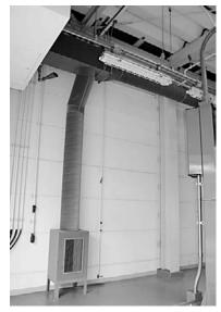
上で必要不可欠な設備の一つである。 ・よる換気・空調が行われている。燃料電池車を整備するが静電気を帯びにくくするため5℃、湿度40%以上の空気水素濃度に応じて換気量が自動的に変わる。また室内空気素濃度を下げることによって火災や爆発が起こらないよう素濃度を下げることによって火災や爆発が起こらないよう整備室内の換気・空調設備。万一の水素漏洩時に室内の水整備室内の換気・空調設備。万一の水素漏洩時に室内の水
